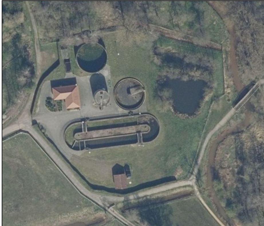
Abb. 5: Luftaufnahme der bestehenden Kläranlage. Der Gasspeicher soll auf dem ovalen ehemaligen Klärbecken errichtet werden, welches inzwischen als Retentionsbecken für Starkregenereignisse genutzt wird. Rechts im Bild ist die Delme erkennbar.
